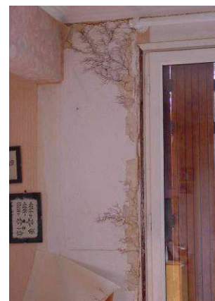
Galeries-tunnels sous une tapisserie
